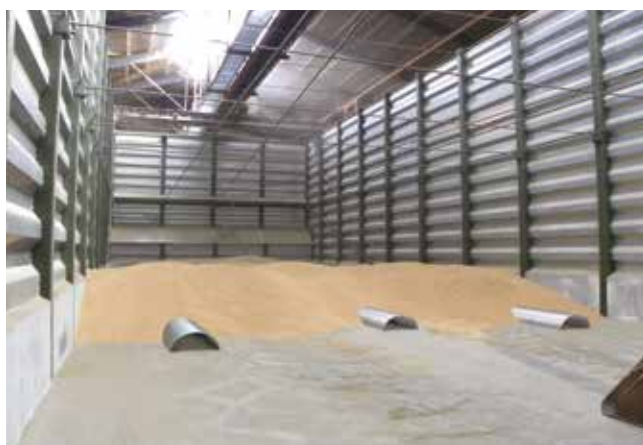
Kanalafstand ved tørring: Korn 100 cm. Frø 80 cm
