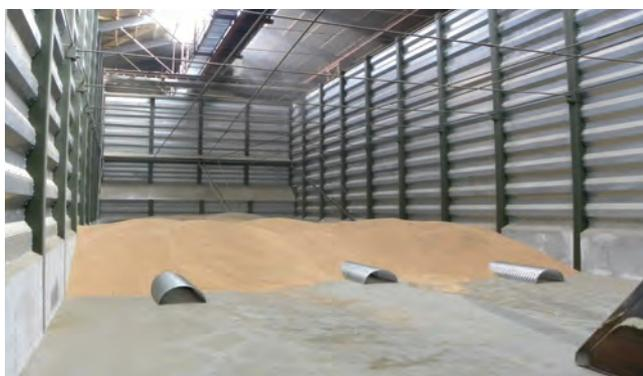
Kanalabstand bei Trocknung: Getreide 100 cm. Saatgut 80 cm
