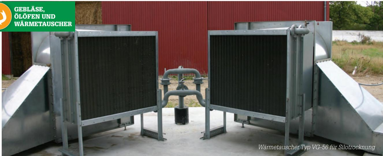
Wärmetauscher Typ VG-56 für Silotrocknung
