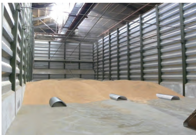
Kanalavstånd vid torkning: spannmål 100 cm, Frö 80 cm
