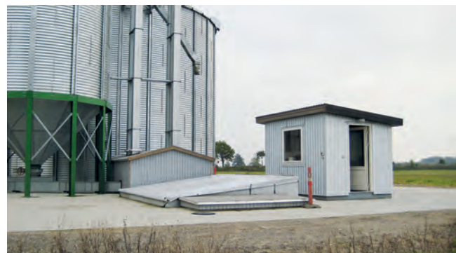
Siloprojekt mit Häuschen für Schaltanlage usw. So platziert das man von dort alle Systeme überblicken kann.
